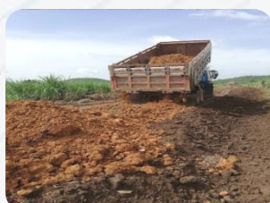
ปรับปรุงถนนยกระดับถนนลูกรัง หมู่ที่ 5 สายบ้านนายอุดม มณีโรจน์
